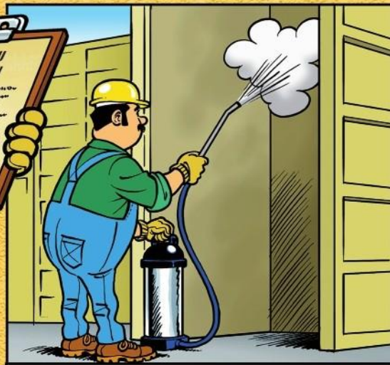
Kanna raketiseõli ühtlase õhukese kihina raketise pinnale.
